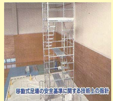
移動式足場の組立て作業
